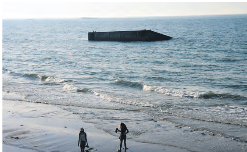
Betonteile im Meer – Überreste künstlicher Hafenanlagen.
